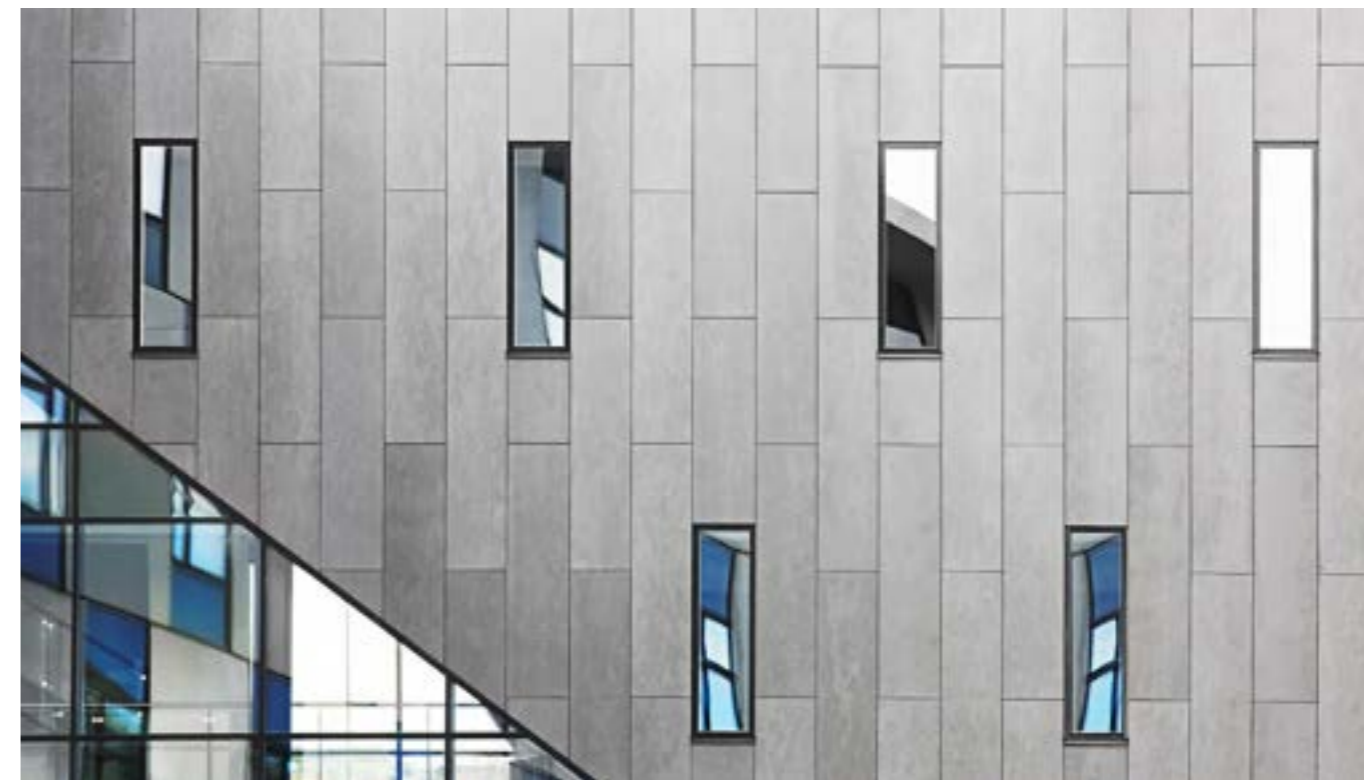
Visionshuset, Ålborg, Denmark. Architect: KPF arkitekter, Ålborg, Denmark. Builder: C.W. Obel Ejendomme A/S, Ålborg, Denmark.
