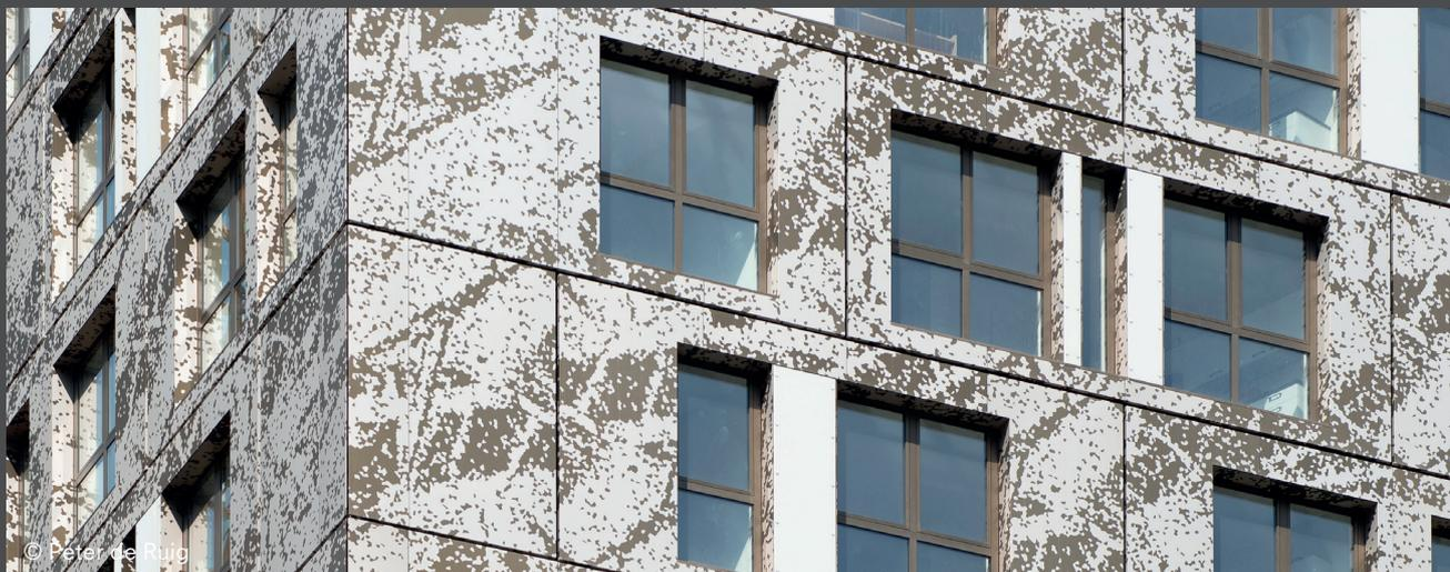
OurDomain, Rotterdam | Tangram Architecten | The pattern on the PANELOX® façade was developed based on an enlarged photograph of the area destroyed by bombs in 1940. | OurDomain, Rotterdam | Tangram Architecten | Das Muster der PANELOX®-Fassade wurde aus einem stark vergrößerten Foto der 1940 durch Bomben zerstörten Umgebung entwickelt.
